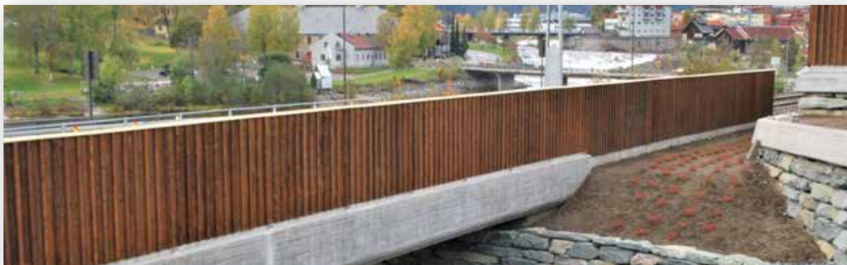
Foto: E134 Kongsberg - Moss Entreprenør AS
